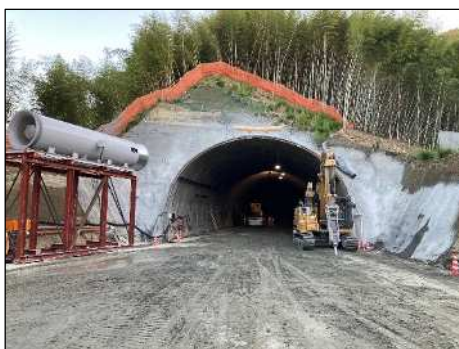
写真① 柿田トンネル掘削状況
